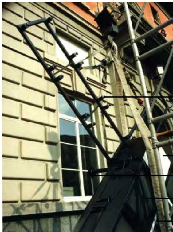
Afbeelding 6. Detail van zwart gemoffeld, metalen frame met enkele Sony PVM-2730QM monitoren (locatie: Locarno, Zwitserland)
