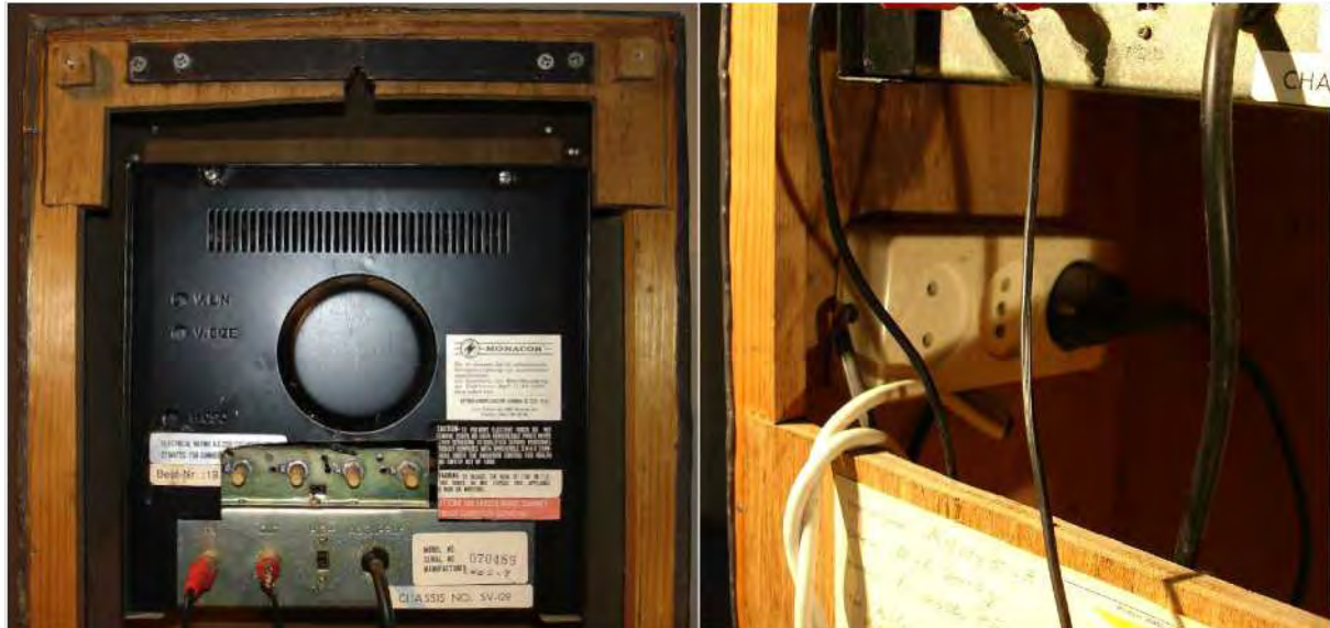
Afbeelding 6. L: ophangstelsel en afstandhouders (houten blokjes), R: ongeaarde contactdoos
