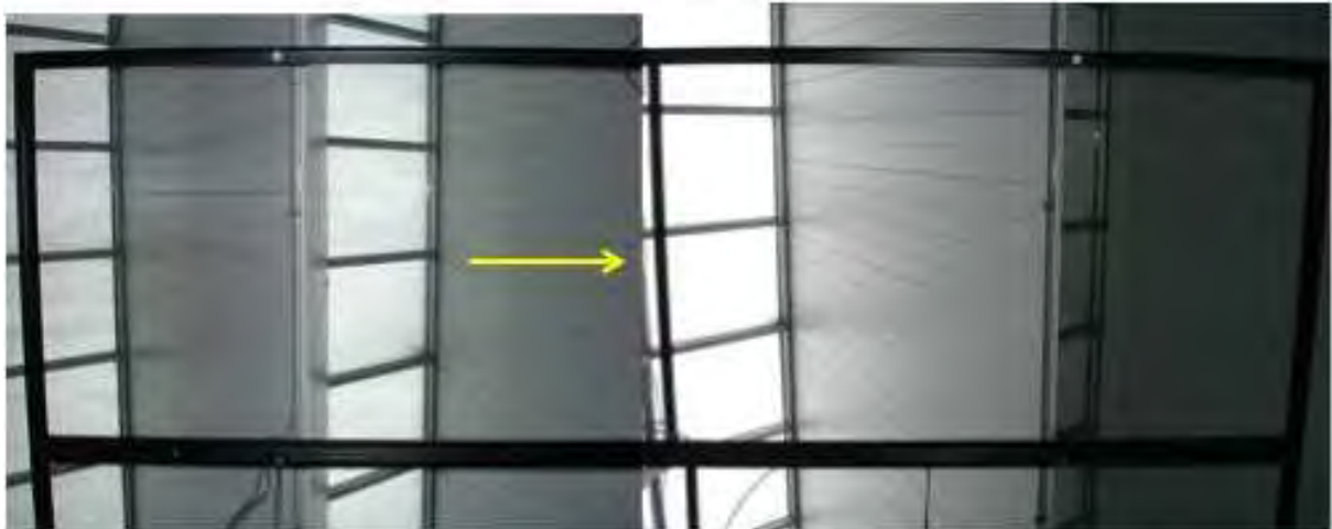
Afbeelding 9. Detail van onderdeel van bovenste metalen frame. Grootte van het onderdeel: 440cm x 133cm. Totale constructie (zowel boven als onder) bestaat uit zes van deze delen. Gele pijl: metalen dwarsligger (één per onderdeel).
